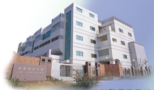
北勢配電變電所
