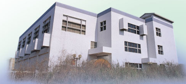
頂園配電變電所
