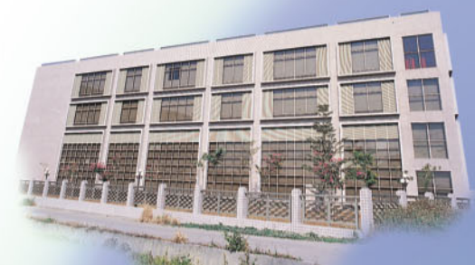
田中配電變電所
