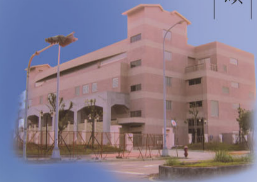
柑園配電變電所
